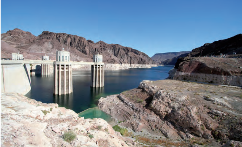
Abb. 3.1.8.2 Wasserkraftwerk | Quelle: Fotolia
