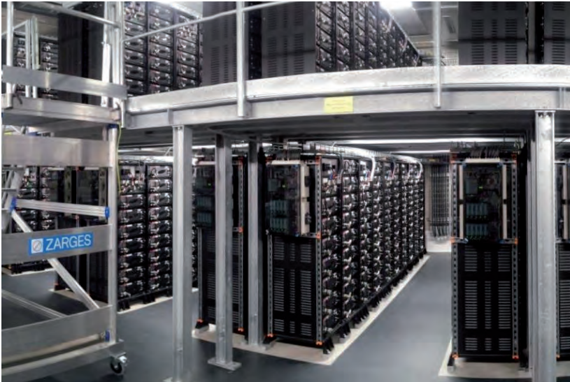
Abb. 3.3.3.2.5: Innenansicht des ersten kommerziell Batteriekraftwerks in Europa: Die Lithium-Ionen-Batterien mit 5 MW Leistung stellen etwa das Regelpotenzial einer konventionellen 50 MW Turbine bereit | Quelle: WEMAG
