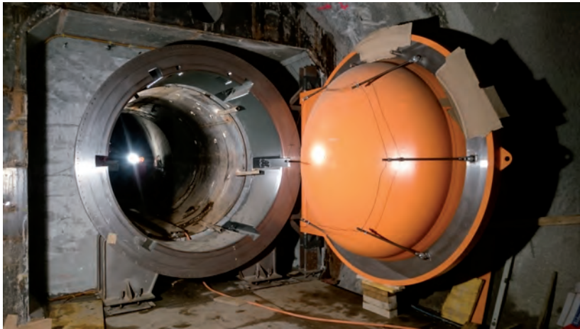
Abb. 3.3.1.3.3: Felskaverne als Druckbehälter | Quelle: zVg
