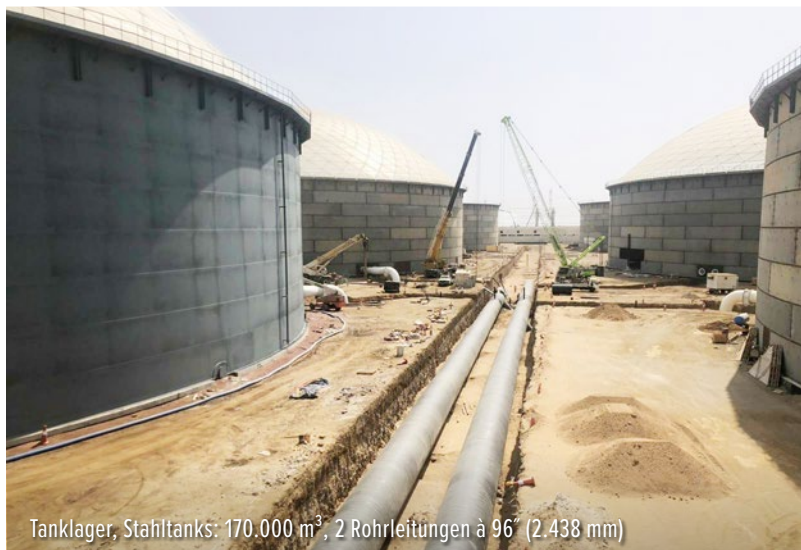
Rohrverlegung, 2 Pipelines à 72" (1.829 mm)
