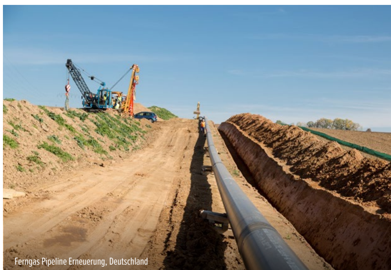
Neubau der Verdichterstation Rimpar, Deutschland
